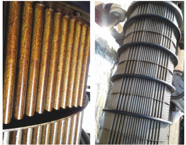
Ölkühlerbündel „vor“ und „nach“ der hydrodynamischen Reinigung
